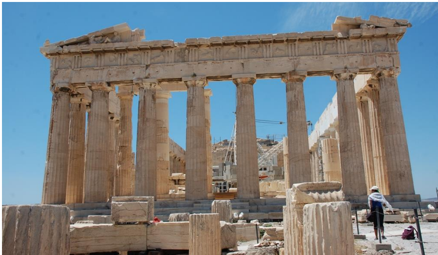
Atene, Partenone con i lavori di restauro in corso (foto di Giuliano Volpe).
