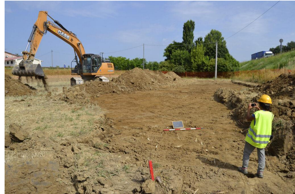
Un esempio di sorveglianza archeologica nel corso di lavori di posa in opera di un metanodotto; controllo del lavoro di scotico con mezzo meccanico.
